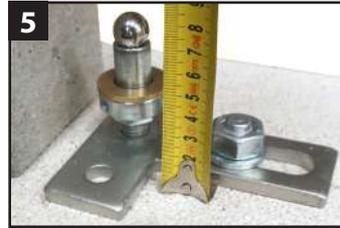
5 Mettre à la côte souhaitée le bas du portail par rapport au seuil (haut de 24) la rondelle laiton si utilisée).
