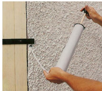
3. Nettoyer à l'aide d'une pompe soufflante pour un meilleur ancrage, la qualité de la fixation en dépend.
