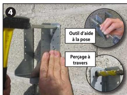
4 Positionner le 1er clou à travers le sabot de charpente et répéter les étapes 2, 3, 4 pour chaque ancrage du sabot.
