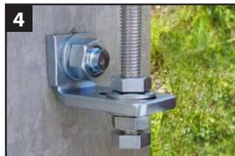
4 Mettre en place la tige filetée avec les 2 écrous-rondelles de part et d'autre de la platine. Puis mettre en place l'écrou plat.
