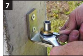
7 Pour maintenir la hauteur, bloquer l'ensemble (bague et écrou plat) avec la clé de 22 et la tige lisse.
