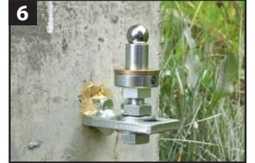
6 Mettre en place la rondelle laiton ou la bille. *Mettre à la côte le bas du portail par rapport au seuil. La côte est donnée par le haut de la rondelle laiton si elle est utilisée.*
