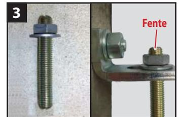
3 Pré-monter l'écrou-rondelle sur la tige filetée Ø14 et enfilez au travers de la platine.
