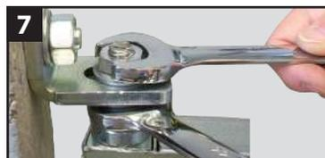
7 Serrer les 2 écrous-rondelles (clé de 22) en même temps (tout en vérifiant l'aplomb).
