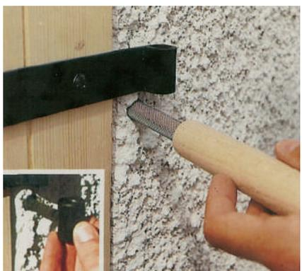
4. **EN MAÇONNERIE CREUSE:** Mettre en place le filtre à l'aide de l'outil de pose
