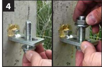
4 Enfiler la tige fileté Ø14x70 au travers de la platine. Visser le premier écrou-rondelle par dessous puis le second par dessus (bloquer légèrement).
