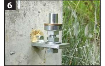
6 Mettre en place la rondelle laiton. *Mettre à la côte le bas du portail par rapport au seuil. La côte est donnée par le haut de la rondelle laiton si elle est utilisée.*
