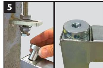
5 Mettre la bague cylindrique dans le carré du portail. Portail prêt à être fixé.
