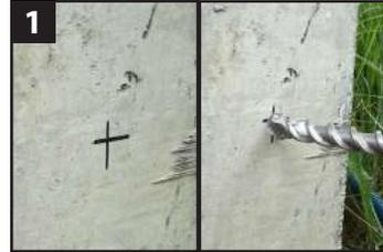
1 Tracer et pré-percer à Ø8mm, puis percer à Ø22mm (profondeur + ou - 130mm)
