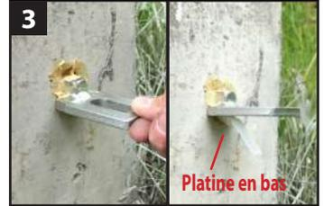
3 Enfoncer la tige avec la platine et mettre en place le centreur pour la maintenir de niveau. *Platine en bas*
