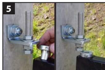
5 Mettre la pièce cylindrique dans le carré du portail puis mettre en place ce dernier.
