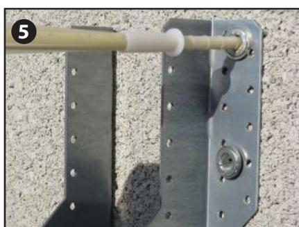
5 Bloquer la rallonge spéciale sur l'embout et injecter la résine en retirant la canule. Répéter cette opération pour les 4 clous.
