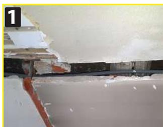
1 Vissage direct dans le bois ou perçage Ø8 dans le béton.
