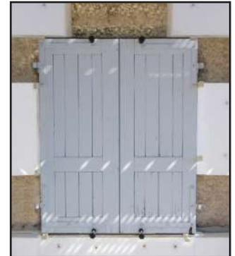
Calage simplifié : volets maintenus sur l'isolant.
