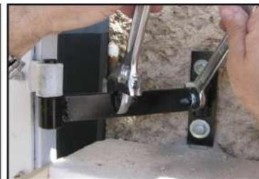
12. Si besoin, redresser le gond en dévissant l'écrou zingué de Ø12 mm et faire bouger le fer plat (clé à molette)..
