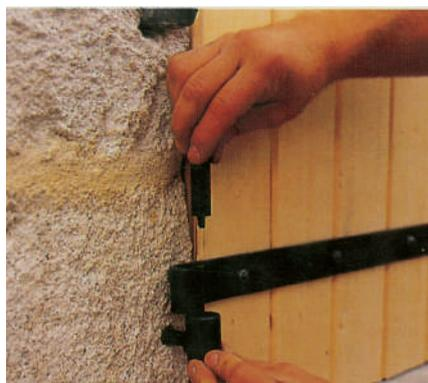
6. Placer **immédiatement** le gond et la clavette autobloquante anti-effraction.
