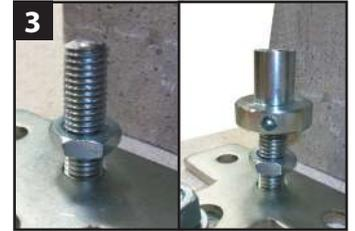
3 Visser l'écrou plat Ø14 puis la bague cylindrique.
