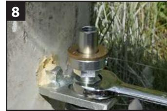
8 Pour maintenir la hauteur, bloquer l'ensemble (bague et écrou plat) avec la clé de 22 et la tige lisse.
