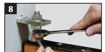
8 Pour une bonne rotation, laisser du jeu : dévisser légèrement la bague cylindrique et bloquer l'écrou sur cette dernière.
