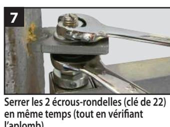
7 Serrer les 2 écrous-rondelles (clé de 22) en même temps (tout en vérifiant l'aplomb).
