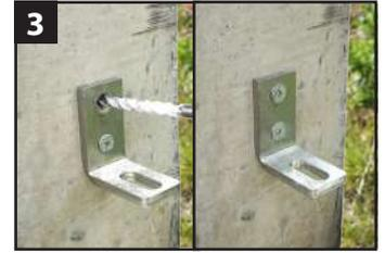
3 Percer  $\varnothing 10\text{mm}$  au travers de la platine. Mettre en place et serrer la seconde cheville.
