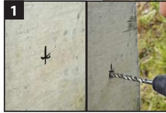
1 Repérer le trou du bas et percer à  $\varnothing 10\text{mm}$ . Faire attention à la distance souhaitée entre le bas du portail et le sol.
