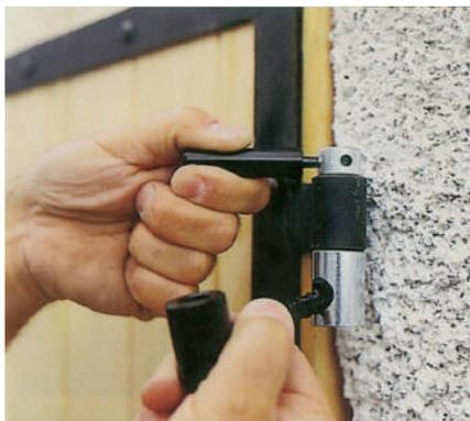
1. Assembler les 2 volets et les maintenir à l'aide de coins. Mettre en place le gabarit orientable et le serrer à l'aide du gond.
