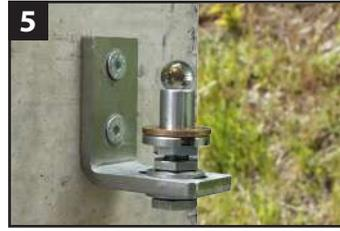
5 Mettre en place la bague cylindrique puis la rondelle laiton ou la bille.
