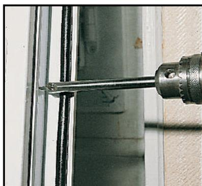
1. Percer le menuiserie au  $\varnothing 8$  mm
