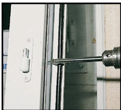
1. Percer le menuiserie au  $\varnothing$  prévu (cf. tableau)
