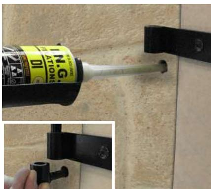
5. Contrôler votre perçage à l'aide du gond et de la clavette puis enfoncer la canule au fond du trou et ensuite injecter la résine en respectant la graduation.
