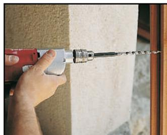
1. Percer le menuiserie au Ø8 mm
