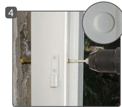
4 Visser à l'aide d'un embout TORX T30 et mettre en place le capuchon orientable, terminé !
