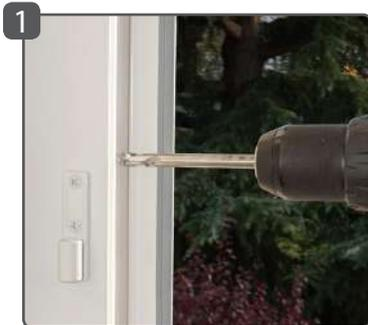
1 Percer la menuiserie  $\varnothing 8,5$  à  $9$  mm (selon l'épaisseur du renfort)
