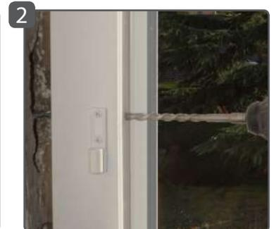
2 Percer  $\varnothing 8$  mm dans le mur à travers la menuiserie
