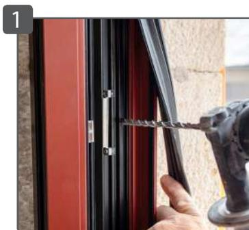
1 Percer la menuiserie  $\varnothing 8$  mm et le mur à travers la menuiserie  $\varnothing 8$  mm
