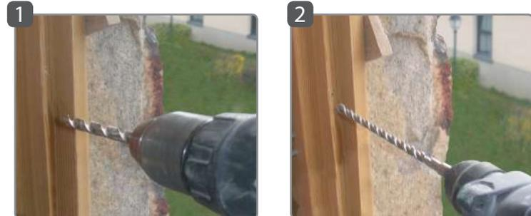
1 Positionner et percer la menuiserie  $\varnothing 8$  mm à l'aide de notre mèche à bois
