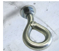
Cheville anneau échafaudage béton - vue en situation
