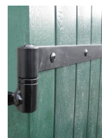
Rondelle d'épaisseur - vue en situation
