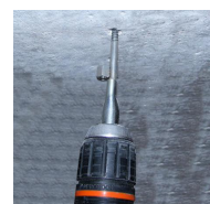
FIX-SUSPENT M6 - mise en oeuvre
