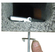
Rondelle Rapid + bascule - mise en oeuvre
