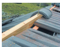
Vis toiture - vue en situation
