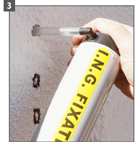
3 Nettoyez le trou à l'aide d'une pompe soufflante pour un meilleur ancrage.
