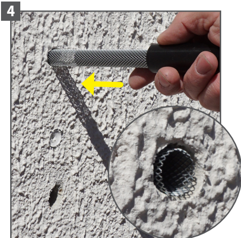
4 Mettez le filtre métallique dans l'outil de pose puis enfoncez l'ensemble.
