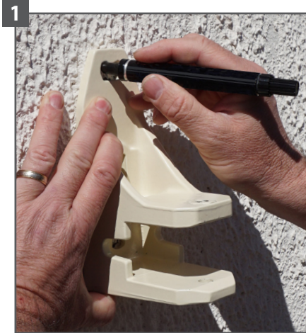
1 Positionnez le support et tracez les repères.
