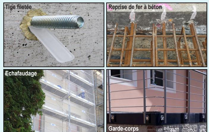
Fixation d'échafaudages, de ponts roulants, toutes applications dans le béton.
