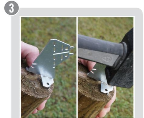
Positionner le connecteur au bord de la jambe de force. Frapper à l'aide d'un marteau sur les deux ailettes.
