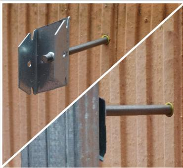
Installer le cavalier sur le FIX-FOURRURE. Clipser la fourrure sur le cavalier.
