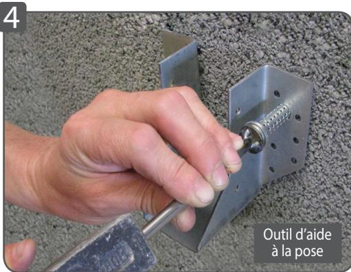
4 Frapper le 1er clou à travers le sabot de charpente à l'aide de l'outil de pose.
