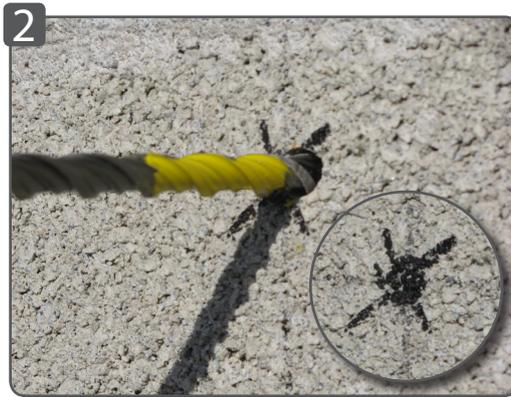
2 Percer Ø10 les alvéoles nécessaires dans le parpaing ou la brique.
