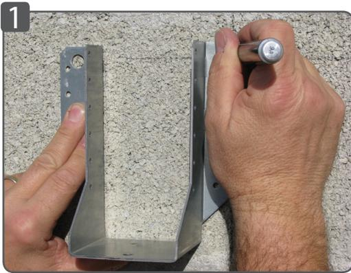
1 Positionner le sabot de charpente et repérer le trou.
