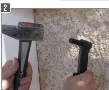
**2** Bloquer la clavette dans le corps de gond à l'aide d'un marteau.
