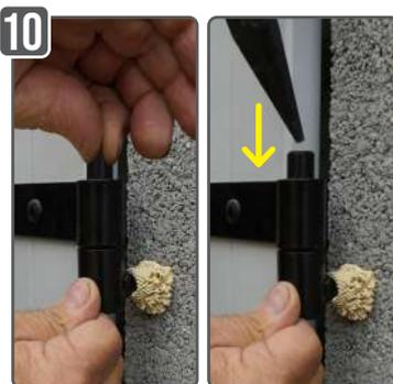
Insérer la clavette (⚠ cône en bas). Important : donner un seul coup de marteau en maintenant le corps de gond pour bloquer la clavette.
