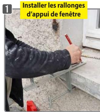
1 Positionner la rallonge sur l'appui de fenêtre et tracer un repère.
