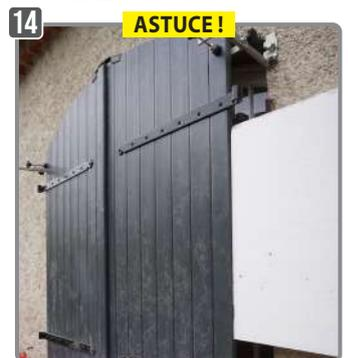
14 **ASTUCE !** Placer une plaque d'isolant contre le volet pour contrôler le déport (tenir compte de la colle et de la finition).
