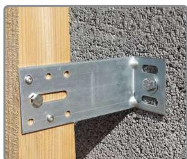
Les équerres de bardage sont utilisées pour la pose d'ossature bois ou métallique.
