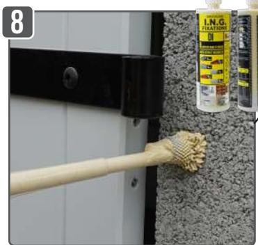
Seule notre clavette permet ce contrôle. Une fois effectué, injecter la résine en respectant la graduation.
