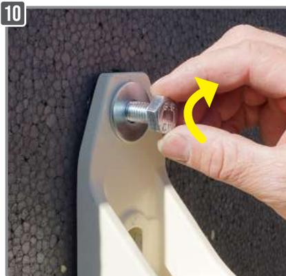
10 Vissez. La rondelle d'appui évite l'écrasement de l'isolant.
