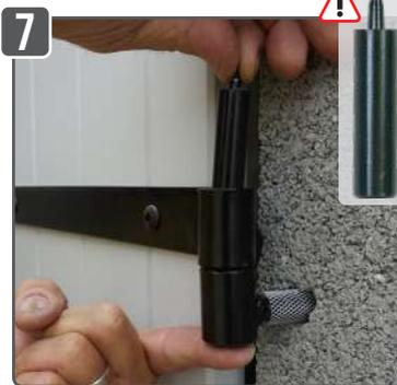
Avant d'injecter la résine, contrôler si le perçage est correct à l'aide du gond. Pour cela, positionner le corps de gond dans le trou et faire descendre la clavette (⚠ cône en l'air) dans le gond.
