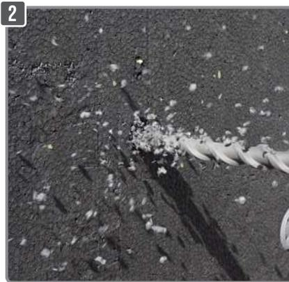
2 Percez Ø 20 mm à travers l'isolant.
