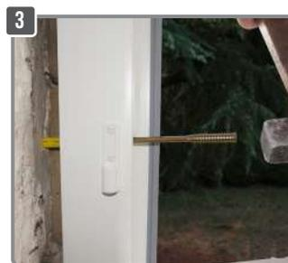
3 Enfoncer la vis TOP-ROC jusqu'au gros filetage avec la cheville et visser à l'aide d'un embout TORX T30
