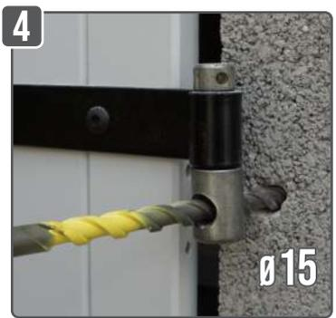
Percer avec une mèche Ø 15 mm, en respectant la profondeur de perçage grâce au repère jaune. Une bonne profondeur de perçage = gain de temps et économie de résine.
