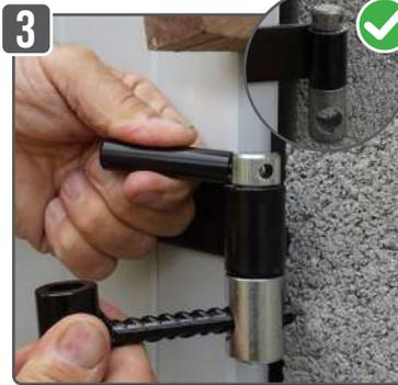
Serrer le gabarit à l'aide du corps de gond et de la clavette. Positionner le gabarit de biais pour éviter de casser l'arête.
