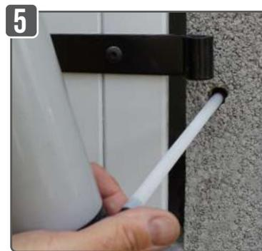
Important : pour un meilleur ancrage, nettoyer à l'aide d'une pompe soufflante, la qualité de la fixation en dépend.
