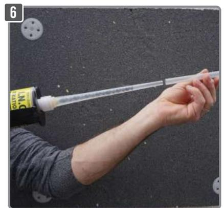
6 Placez la rallonge sur l'embout mélangeur et faites monter la résine jusqu'au bout.
