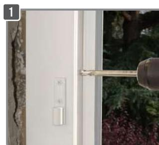
1 Prépercer la menuiserie Ø 8 mm à l'aide de notre mèche spéciale PVC puis la positionner
