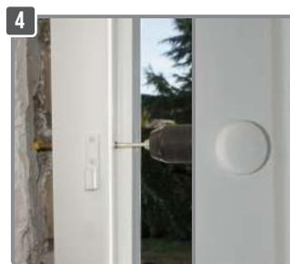
4 Visser à l'aide d'un embout TORX T30 et mettre en place le capuchon orientable, terminé !
