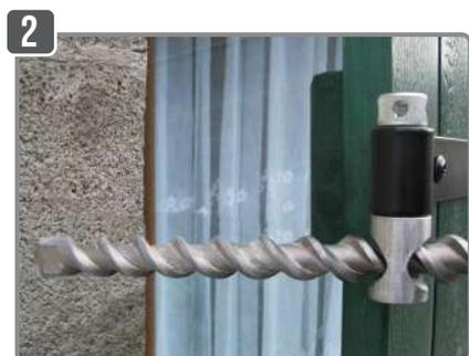
2 Percer au travers du gabarit de perçage.
