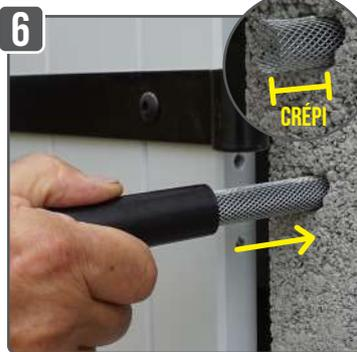
Mettre en place le filtre à l'aide de l'outil de pose. Laisser dépasser le filtre de l'épaisseur du crépi pour une meilleure tenue.
