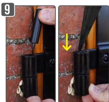
9 Insérer la clavette (⚠ cône en bas). Important : donner un seul coup de marteau en maintenant le corps de gond pour bloquer la clavette.
