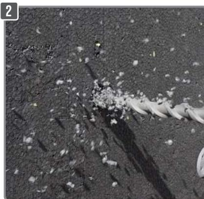
2 Percez  $\varnothing$  20 mm à travers l'isolant.
