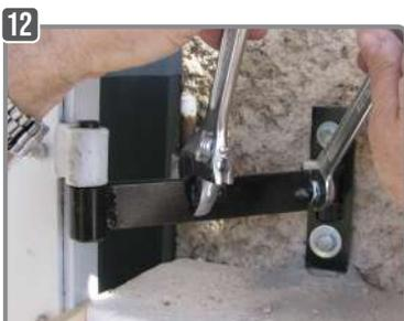
**12** Si besoin, on peut redresser le gond en dévissant l'écrou zingué (clé de 17) en faisant bouger le fer plat à l'aide d'une clé à molette.
