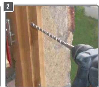
2 Percer le mur Ø 8 mm à travers la menuiserie
