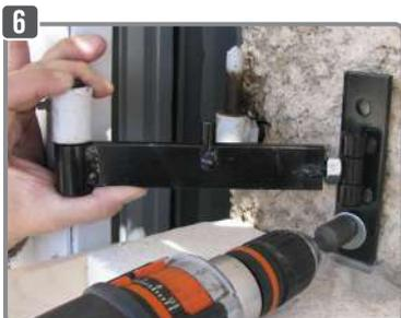
**6** Visser le tirefond avec la grosse rondelle (douille de 13) jusqu'à ce que le gond soit maintenu.
