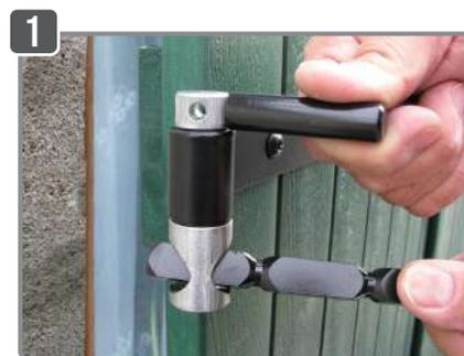
1 Mettre en place le gabarit de perçage et le serrer à l'aide de la clavette et de la queue du gond.
