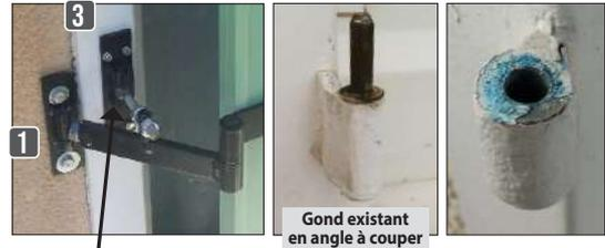
Platine à fixer sur le précadre acier pour remplacer le gond existant
