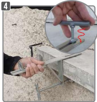
4 Visser manuellement la rallonge sur l'appui de fenêtre à l'aide de la clé.
