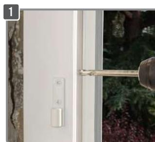
1 Prépercer la menuiserie Ø 8,5 à 9 mm (selon l'épaisseur du renfort) puis la positionner
