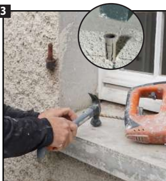
3 Enfoncer la cheville à l'aide d'un marteau.
