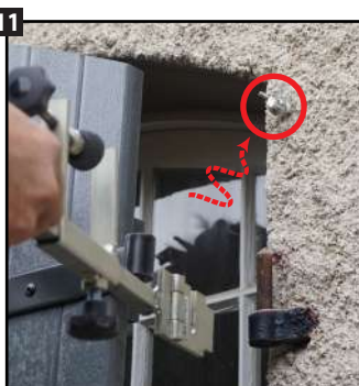
11 Insérer la vis papillon et positionner le gabarit d'angle.
