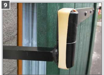
9 Mettre l'élastique pour maintenir le gond pendant le temps de séchage de la résine.
