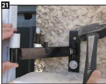
21 Si besoin, grâce au trou plus large, positionner parfaitement le gond en tapotant.
