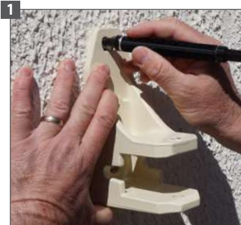
1 Positionnez le support et tracez les repères
