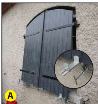
A Déport du volet à l'aide du gabarit appui de fenêtre.
