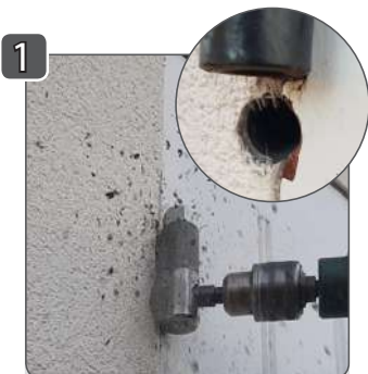
Perçage dans le bloc isolant 3 étapes
