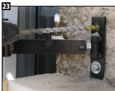
23 Percer Ø10 le trou supérieur à travers la platine.
