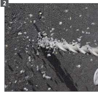
2 Percez Ø 20 mm à travers l'isolant
