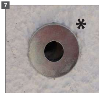
Une fois l'isolation finie, n'oubliez pas la rondelle d'appui pour éviter l'écrasement de l'isolant
