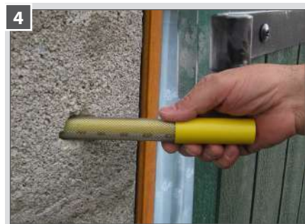
4 Mettre en place le filtre à l'aide de l'outil de pose.
