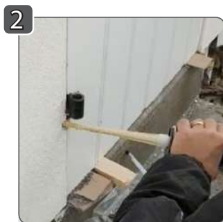
Injection de la résine dans le bloc isolant
