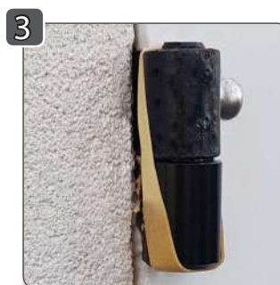
Installation du gond dans le bloc isolant
