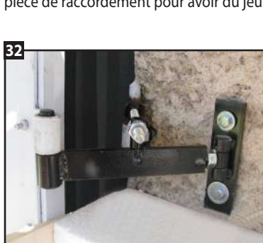
32 Gond I.N.G. ISO mis en place, il ne reste plus qu'à l'isoler.
