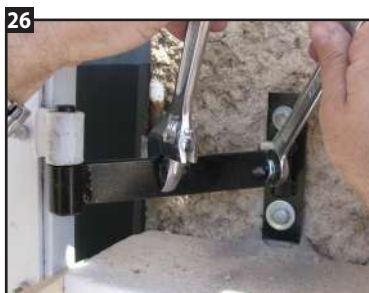
26 Si besoin, on peut redresser le gond en dévissant l'écrou zingué (clé de 17) en faisant bouger le fer plat à l'aide d'une clé à molette.
