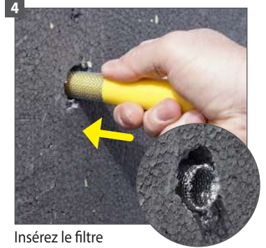
4 Insérez le filtre à l'aide de l'outil de pose
