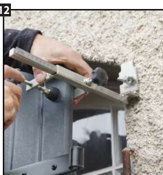
12 Ajuster la longueur selon l'épaisseur de l'isolant. Répéter l'opération de l'autre côté du volet.
