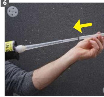
6 Placez la rallonge sur l'embout mélangeur et faites monter la résine jusqu'au bout
