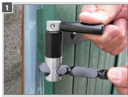
1 Mettre en place le gabarit de perçage et le serrer à l'aide de la clavette et de la queue du gond.
