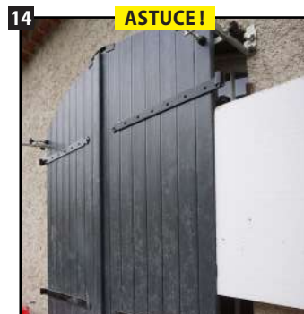
14 Placer une plaque d'isolant contre le volet pour contrôler le déport (tenir compte de la colle et de la finition).
