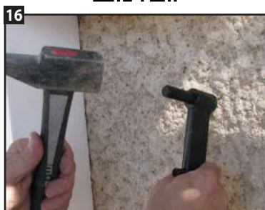
16 Bloquer la clavette dans le corps de gond à l'aide d'un marteau.
