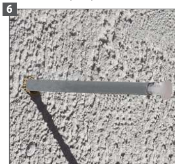
6 La fixation est mise en place. Il ne reste plus qu'à isoler
