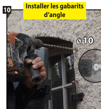
10 Percer Ø 10 et enfoncer la cheville blanche. Mallette : réf. A130110
