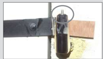
9 Mettre l'élastique pour maintenir le gond pendant le temps de séchage de la résine.
