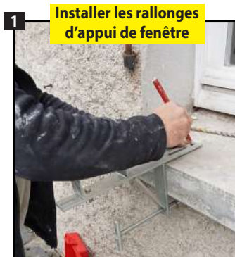
1 Positionner la rallonge sur l'appui de fenêtre et tracer un repère. Mallette : réf. A130112
