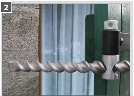
2 Percer au travers du gabarit de perçage.
