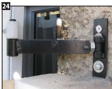
24 Mettre en place la cheville blanche à travers la platine.
