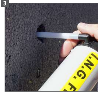
3 Nettoyez le trou à l'aide d'une pompe soufflante
