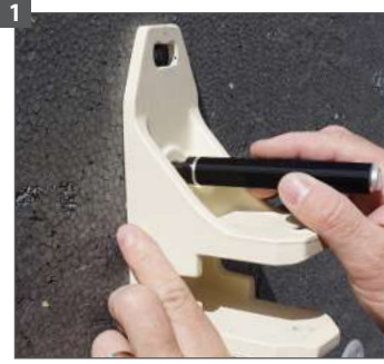
1 Positionnez le support et tracez les repères
