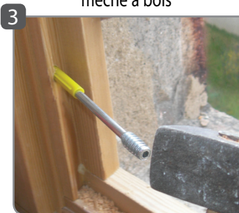
3 Enfoncer la vis TOP-ROC avec la cheville
