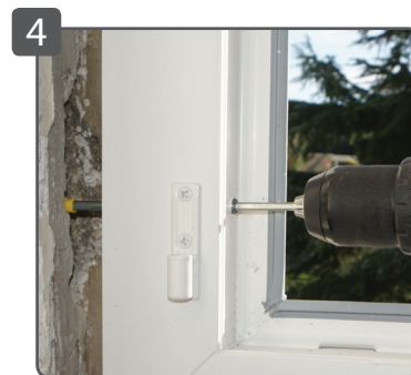
4 Visser à l'aide de l'embout 6 pans fourni, terminé!
