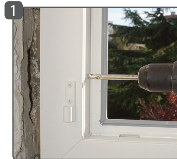
1 Positionner et percer la menuiserie \varnothing 8,5 à 9 mm (selon l'épaisseur du renfort)
