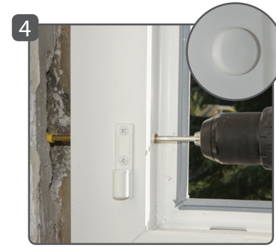
4 Visser à l'aide de l'embout 6 pans fourni et mettre en place le capuchon orientable, terminé !
