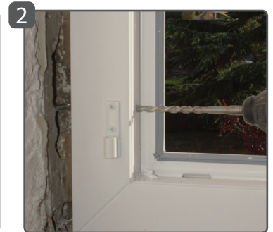
2 Percer \varnothing 8 mm dans le mur à travers la menuiserie
