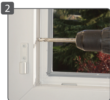
2 Percer la menuiserie Ø 8 mm
