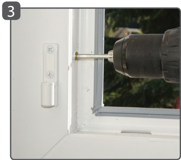
3 Enfoncer la vis TOP-ROC et visser à l'aide de l'embout 6 pans fourni
