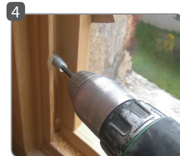
4 Visser à l'aide de l'embout 6 pans fourni, terminé !
