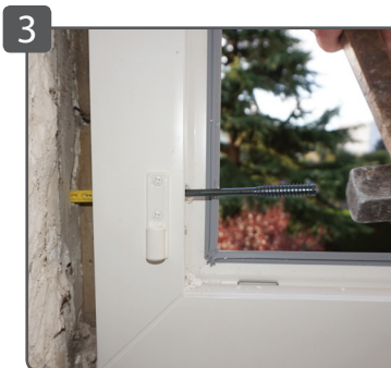
3 Enfoncer la vis TOP-ROC avec la cheville
