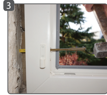
3 Enfoncer la vis TOP-ROC avec la cheville
