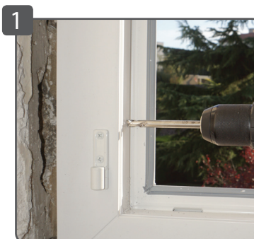
1 Positionner et percer la menuiserie Ø 8 mm
