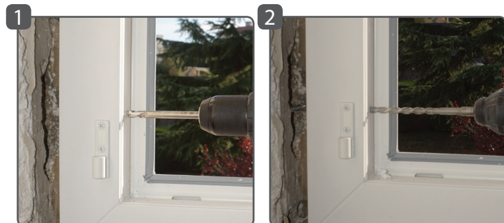
Positionner et percer la menuiserie \varnothing 8 mm à l'aide de notre mèche spéciale PVC
