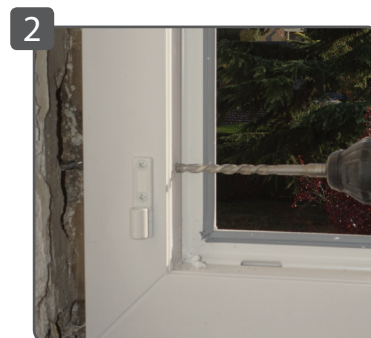
2 Percer Ø 8 mm dans le mur à travers la menuiserie
