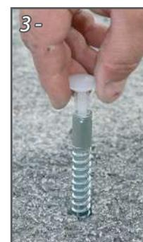
Insérez le FIX-ASPHALTE à l'aide du bouchon fourni
