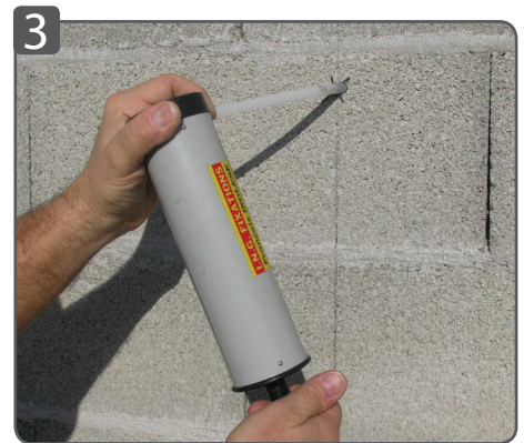
3 Enlever la poussière à l'aide d'une pompe soufflante.
