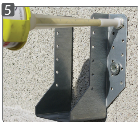
5 Injecter la résine en retirant la canule et en respectant les graduations. Répéter cette opération pour chaque clou.
