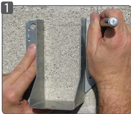
1 Positionner le sabot de charpente et repérer le trou.
