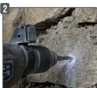
2 Percer Ø 8 mm (toujours de niveau)
