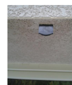
Battement haut ISO pour espagnolette - après isolation
