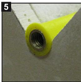
Débloquer l'écrou, dévisser le contre-écrou. La cheville est prête à recevoir la pièce à fixer.
