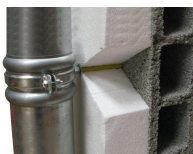
Collier de descente d'eaux pluviales - vue en situation
