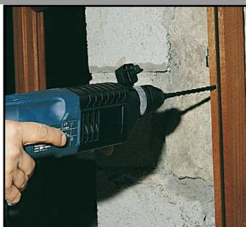
2. Percer un trou Ø8 mm dans le mur au travers de la menuiserie
