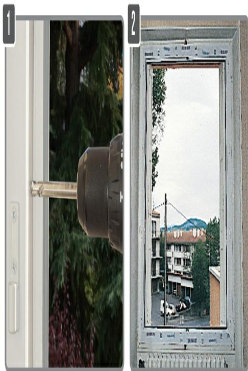
1 Prépercer la menuiserie  $\varnothing 8,5$  à  $9$  mm
