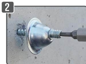
2 Mettre la rosace sur la patte à vis et visser directement dans le béton à l'aide d'un embout TORX T15
