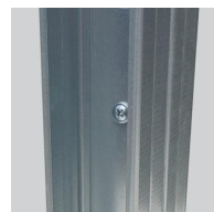
Vis ossature plaque de plâtre - montants dos à dos
