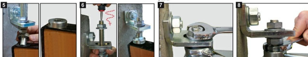
5 Mettre la bague cylindrique dans le collet relevé de l'équerre. Le portail est prêt à être fixé.
