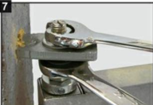
Serrer les 2 écrous-rondelles (clé de 22) en même temps (tout en vérifiant l'aplomb).
