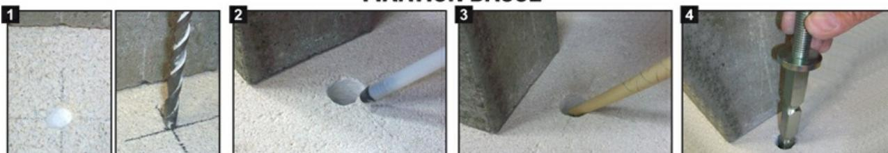
1 Tracer et pré-percer à Ø8mm (pour être le plus précis possible)
