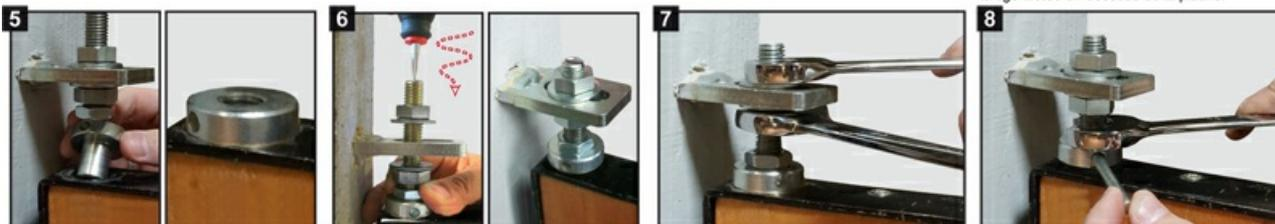
5 Mettre la bague cylindrique dans le collet relevé de l'équerre. Le portail est prêt à être fixé.
