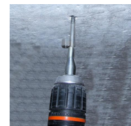
FIX-SUSPENT M6 - mise en oeuvre
