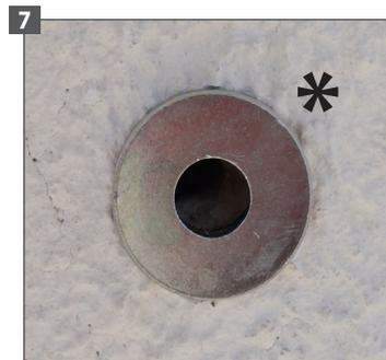
7 Une fois l'isolation finie, n'oubliez pas la rondelle d'appui pour éviter l'écrasement de l'isolant.
