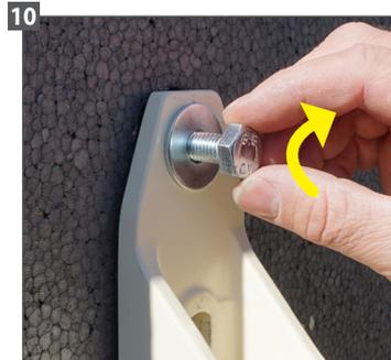
11 Vissez. La rondelle d'appui évite l'écrasement de l'isolant.
