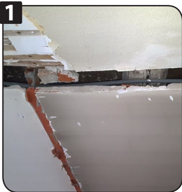
1 Vissage direct dans le bois ou perçage \varnothing 8 dans le béton.
