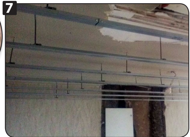
3 Visser le FIX-FOURRURE à l'aide de l'outil de pose.
