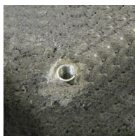
FIX-ASPHALTE - vue en situation
