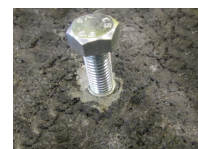
FIX-ASPHALTE - vue en situation
