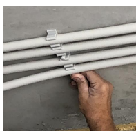
FIX-RING Multi électricité - clipsage à la main
