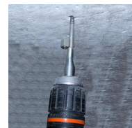
FIX-SUSPENT M6 - mise en oeuvre
