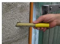
Filtre métallique - vue en situation
