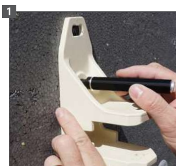
Positionnez le support et tracez les repères.
