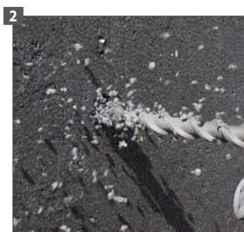
Percez Ø 20 mm à travers l'isolant.
