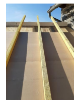
Vis toiture - vue en situation 3
