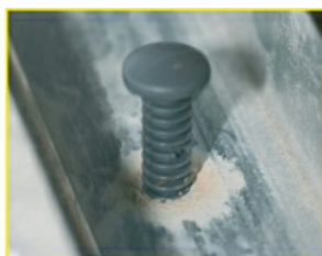
2- Positionner le Fix-Rail
