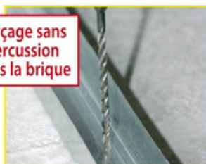
1- Percer à Ø6 mm
