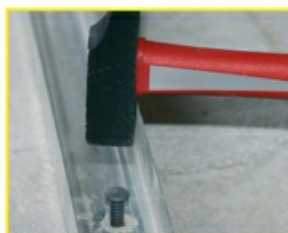
3- Enfoncer à l'aide d'un marteau
