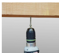
Piton rénovation mâle M6 - mise en oeuvre
