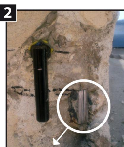
Couper le gond puis mettre en place la pièce pour gond en angle
