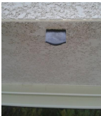
Battement haut ISO pour espagnolette - après isolation
