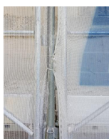
Collier pour filet de protection de façade - vue en situation
