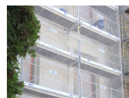
Collier pour filet de protection de façade - vue en situation
