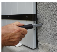
Outil de pose pour filtre métallique - vue en situation
