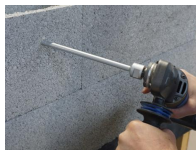
Trépan parpaing - vue en situation
