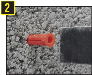
2 Enfoncer la cheville à l'aide d'un marteau
