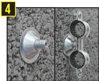
4 Visser le collier sur la patte à vis. Terminé !
