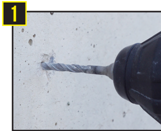
1 Percer Ø 5 mm : GAIN DE TEMPS !
