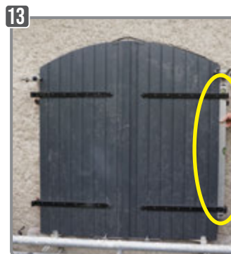
13 Le volet est mis en place ! Vérifier l'aplomb et le niveau à l'aide d'un niveau à bulle.
