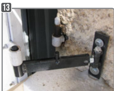
13 Le corps de gond est en place.
