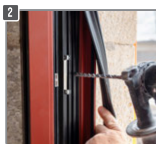
2 Percer le mur Ø 8 mm à travers la menuiserie
