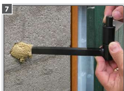
7 Mettre en place le gond et la clavette immédiatement après avoir injecté la résine.
