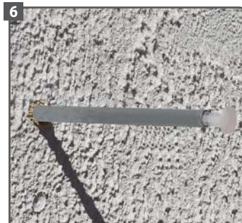
6 La fixation est mise en place. Il ne reste plus qu'à isoler
