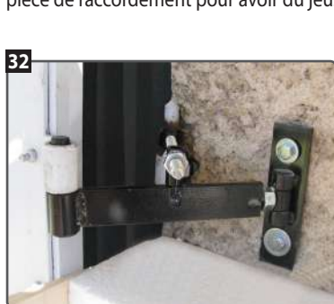
32 Gond I.N.G. ISO mis en place, il ne reste plus qu'à l'isoler.
