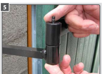
5 Pour contrôler si le perçage est correct : on peut mettre le gond et positionner la clavette à l'envers pour pouvoir la retirer.
