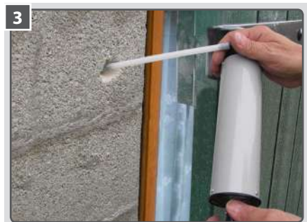
3 Important : Pour un meilleur ancrage, nettoyer le trou à l'aide d'une pompe soufflante.
