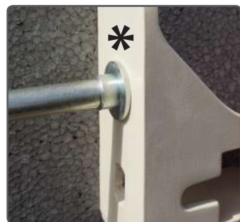
10 La rondelle d'appui est en place derrière le support pour éviter l'écrasement
