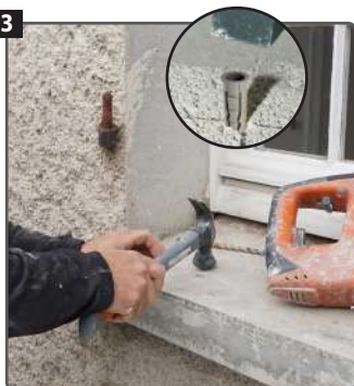
Enfoncer la cheville à l'aide d'un marteau.
