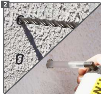
2 Percez Ø 20 mm puis nettoyez le trou à l'aide d'une pompe soufflante
