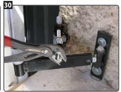
30 Serrer la tige filetée sur l'ancien gond à l'aide d'une pince.
