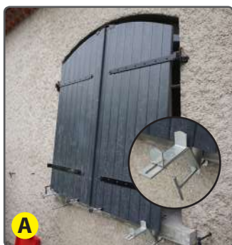
Déport du volet à l'aide du gabarit appui de fenêtre.
