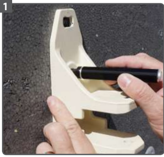
1 Positionnez le support et tracez les repères
