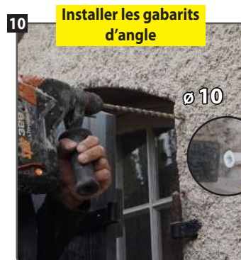
Percer Ø 10 et enfoncer la cheville blanche. Mallette : réf. A130110
