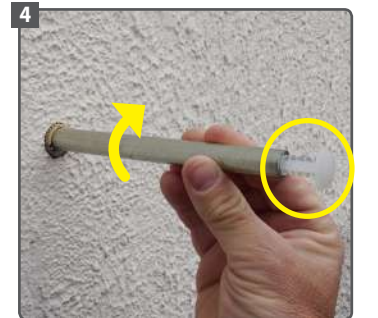
4 Vissez et enfoncez en même temps la fixation N'oubliez pas le bouchon de protection
