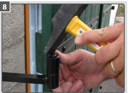
8 Pour bloquer la clavette autobloquante, donner un seul coup de marteau.
