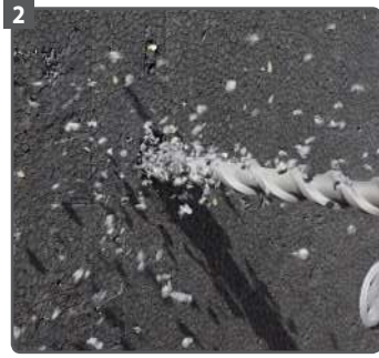
2 Percez Ø 20 mm à travers l'isolant
