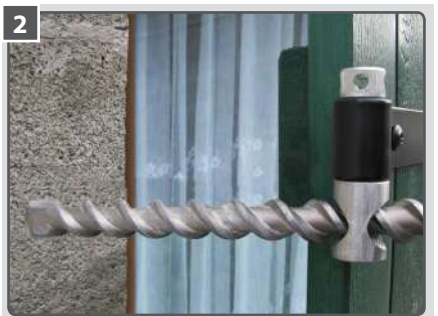
2 Percer au travers du gabarit de perçage.
