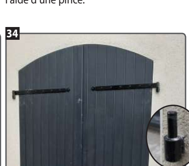
30 Serrer la tige filetée sur l'ancien gond à l'aide d'une pince.
