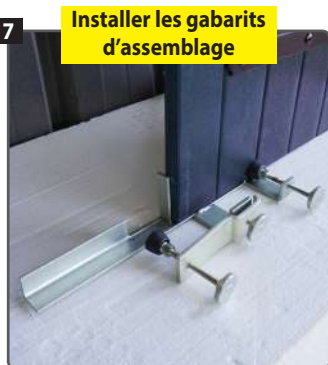
Assembler les volets à l'aide de notre gabarit.
