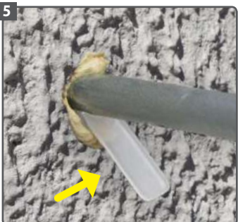
5 Mettez la fixation de niveau à l'aide du centreur
