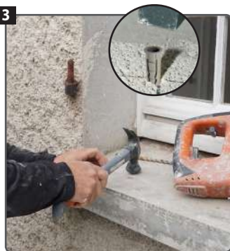
Enfoncer la cheville à l'aide d'un marteau.
