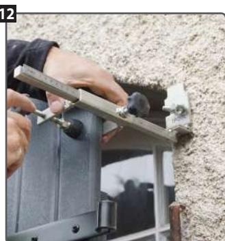
Ajuster la longueur selon l'épaisseur de l'isolant. Répéter l'opération de l'autre côté du volet.
