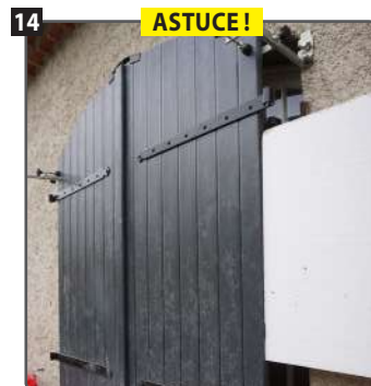
Placer une plaque d'isolant contre le volet pour contrôler le déport (tenir compte de la colle et de la finition).
