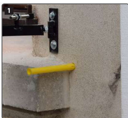
1 Percer la maçonnerie et insérer la cheville grande longueur.
