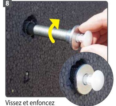
8 Vissez et enfoncez en même temps la fixation
