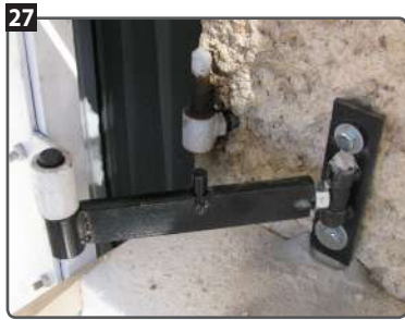
27 Le corps de gond est en place.
