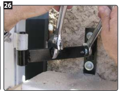
26 Si besoin, on peut redresser le gond en dévissant l'écrou zingué (clé de 17) en faisant bouger le fer plat à l'aide d'une clé à molette.
