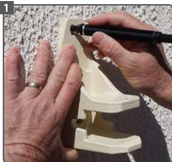
1 Positionnez le support et tracez les repères
