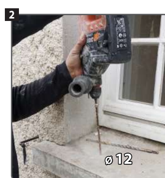
Percer Ø 12 au centre du repère.
