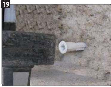
19 Enfoncer la cheville blanche à l'aide d'un marteau.
