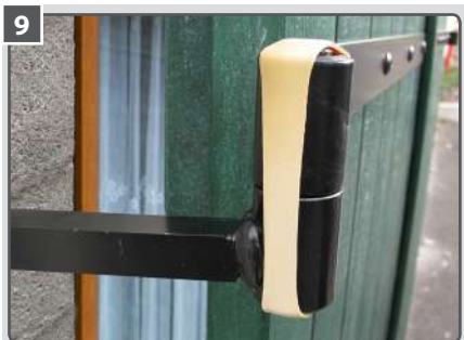
9 Mettre l'élastique pour maintenir le gond pendant le temps de séchage de la résine.
