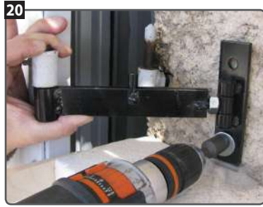
20 Visser le tire-fond avec la grosse rondelle (douille de 13) jusqu'à ce que le gond soit maintenu.
