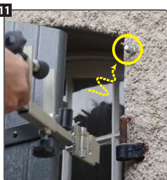
Insérer la vis papillon et positionner le gabarit d'angle.
