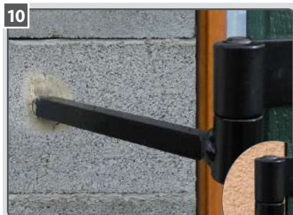
10 Le gond est en place.
