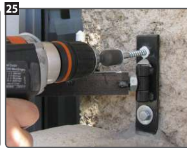
25 Visser le 2ème tirefond à travers la petite rondelle et serrer à fond.
