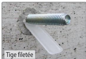
Reprise de fer à béton
