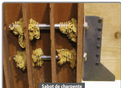
Sabot de charpente sur brique
